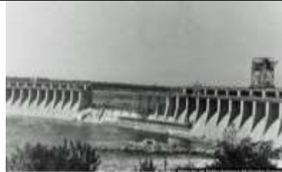
Відновлювальні роботи на греблі ДніпроГЕСу. Середина 1942 року
